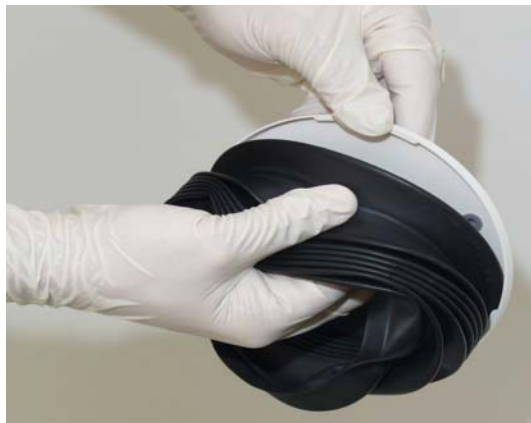
РИСУНОК 7-7 Отсоединение верхней панели от сифона
